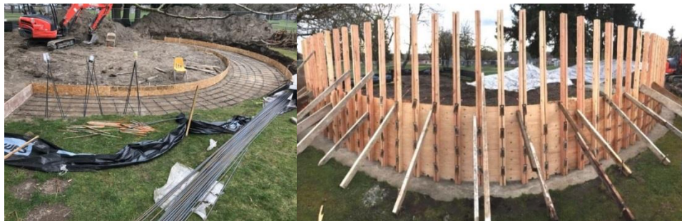
Hình ghi lại diễn tiến việc xây cất Đài Vinh-Danh Chiến-Sĩ Việt Mỹ tại Les Gove Park, Auburn, Tiểu Bang Washington
