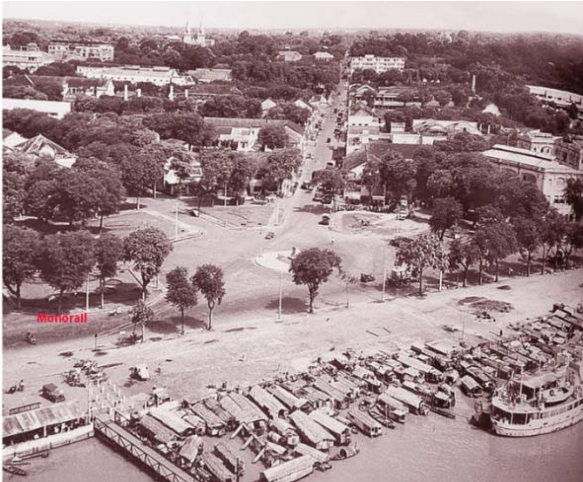
Đường rầy ở công trường Mê Linh
