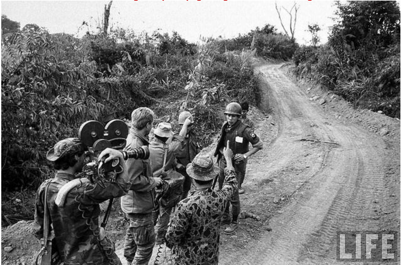
Con đường do Lực lượng Công binh vừa làm xong
